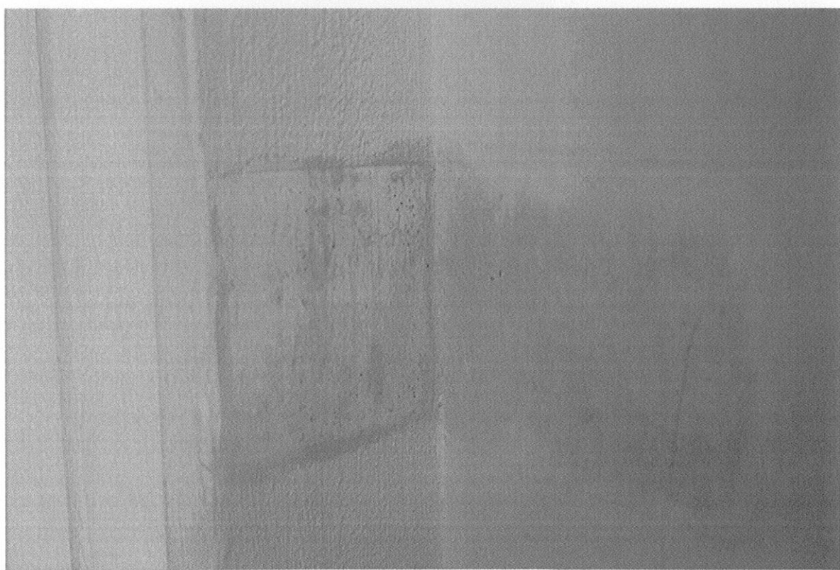
Odmývání broušené omítky destilovanou vodou
